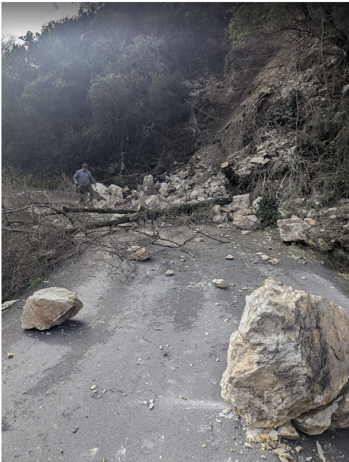
Foto 2- Elementi lapidei provenienti da crolli in parete su Via Castellari
